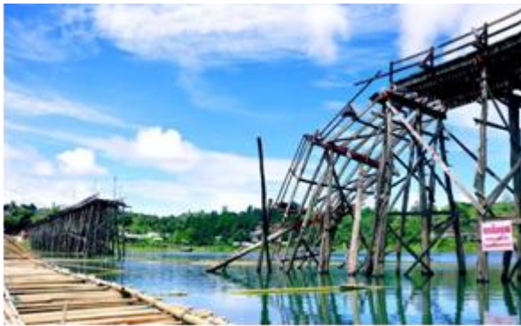
ภาพที่ 1 สภาพสะพานอุตตามนุสรณ์ที่พังจากกระแสน้ำ
