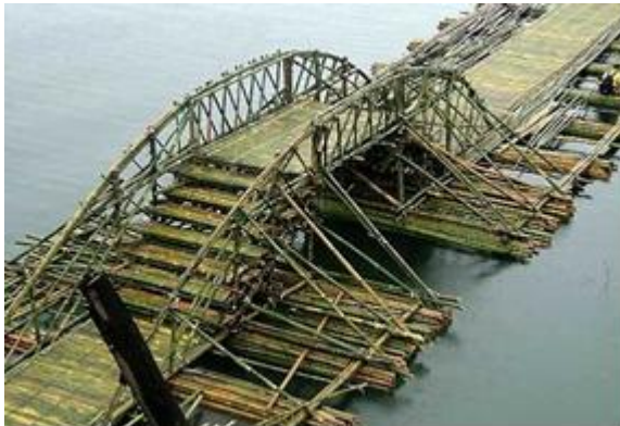
ภาพที่ 2 สะพานไม้ไผ่ลูกบวบที่สร้างมาใช้งานทดแทน
